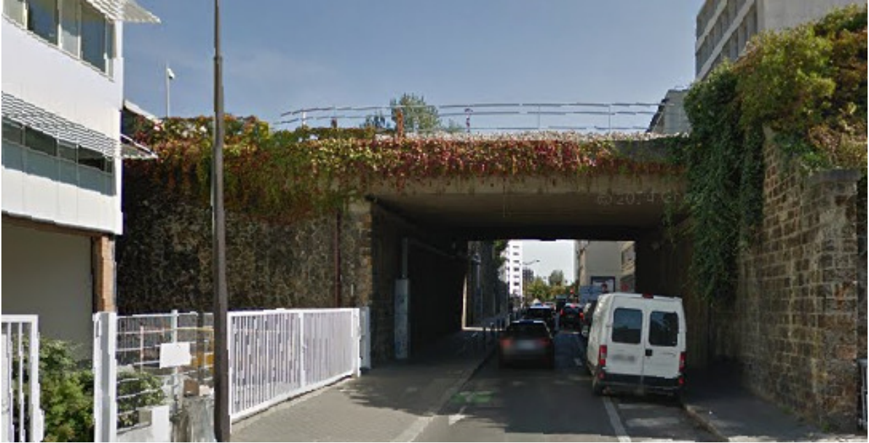
Rue de Lagny, Paris
